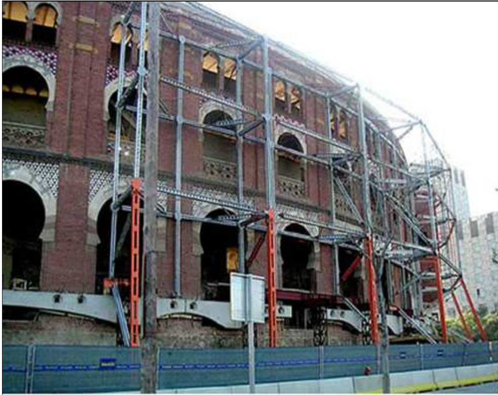
Figura 2: Imagen del sistema de sujeción de la fachada de a plaza de la Arenas de Barcelona, durante su transformación en espacio lúdico comercial.
