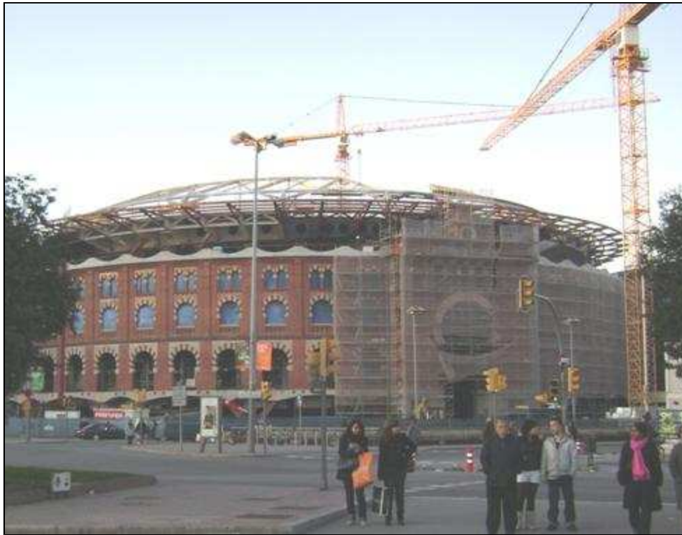
Figura 3. Imagen de la remozada fachada de las Arenas. Se puede observar la construcción del armazón de la cubierta de la plaza de toros. Foto Martín Checa, Diciembre de 2008.
